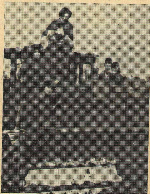
Верхний снимок: вот она, первая плита. Нижний: студенты нифака на строительстве.
